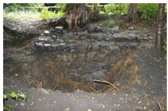
Un sondage d'un mètre de profondeur montre que malgré les arbres qui ont poussé autour, le revêtement intérieur du parapet n'a subi aucune altération à cet endroit.
