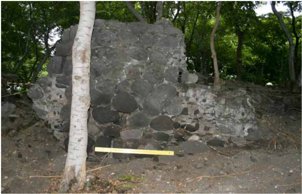
Vestige du mur de l'enceinte sud-est de la batterie, vue de face (avec repère jaune de 1 mètre)
