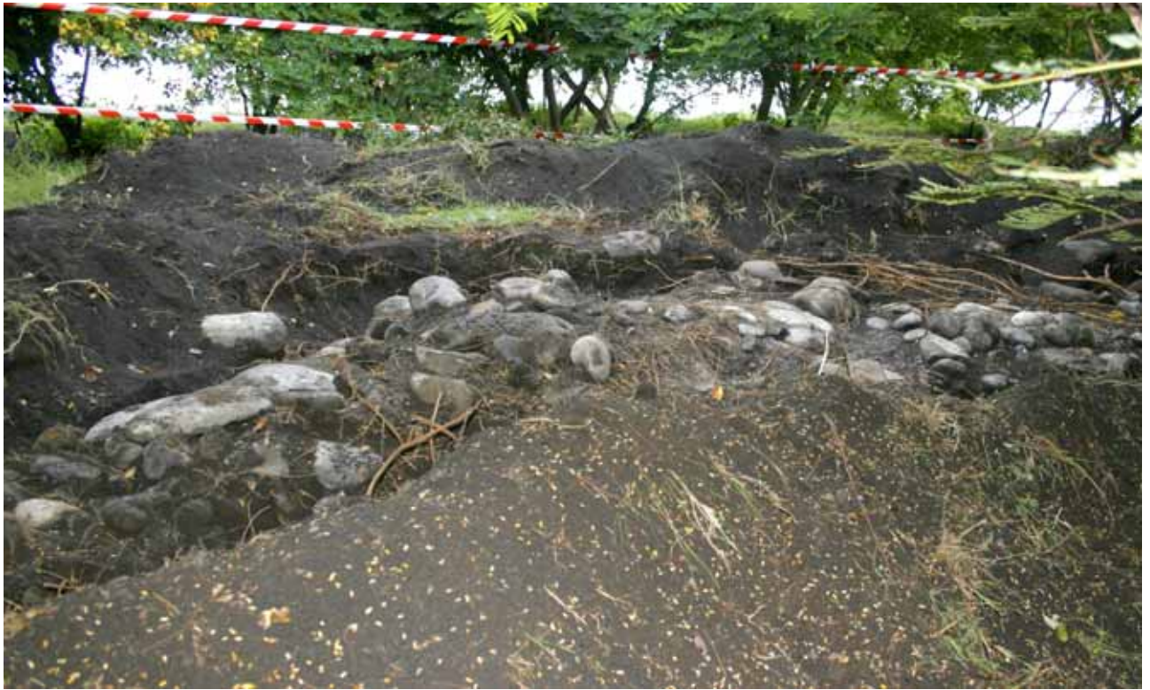
Le revêtement intérieur du parapet se désagrège dans le dernier tiers ouest (en montant vers le nord). A cet endroit l'argamaste qui le compose est très friable.
