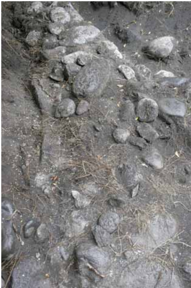
Partie nord-ouest du revêtement très dégradée (détail)
