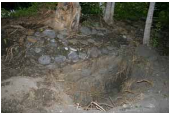
Un sondage d'un mètre de profondeur montre que malgré les arbres qui ont poussé autour, le revêtement intérieur du parapet n'a subi aucune altération à cet endroit.
