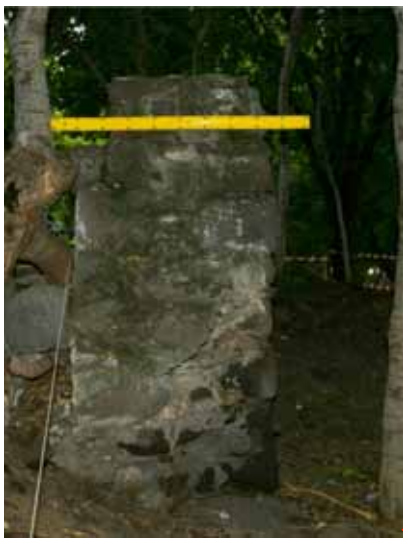
Mur de l'enceinte vue de profil
